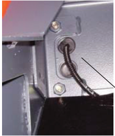
Verlegung des Kabelbaums unterhalb der Dämmmatten Verlegung des Kabelbaums ohne Heizung
